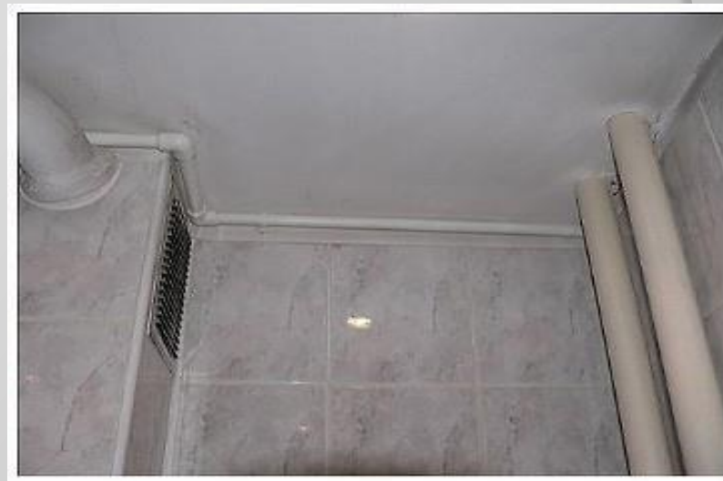
Podłączenie do instalacji w łazience
