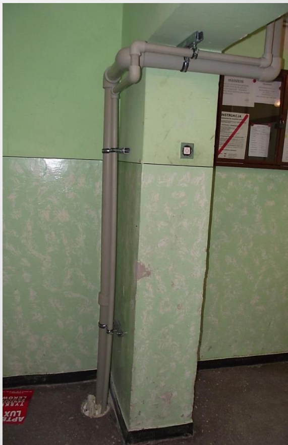
Wyprowadzenie z piwnicy
