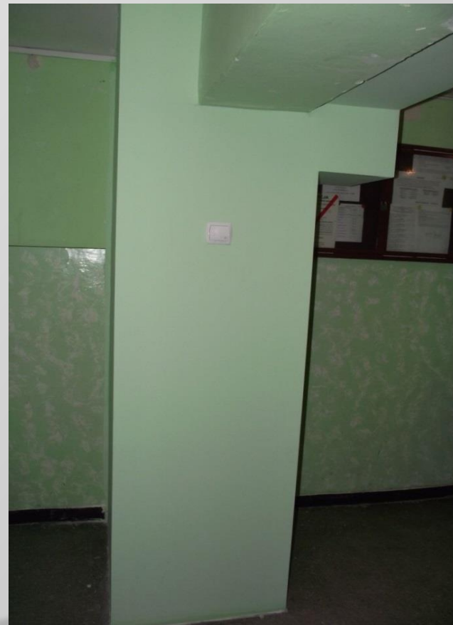
Instalacja po wykonaniu zabudowy
