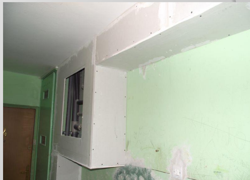
Zabudowa płytami gipsowymi
