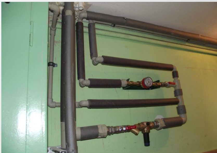
Przygotowanie do zabudowy
