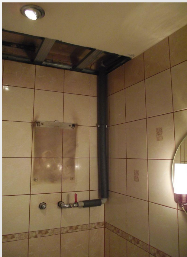
Wykonana w łazience
